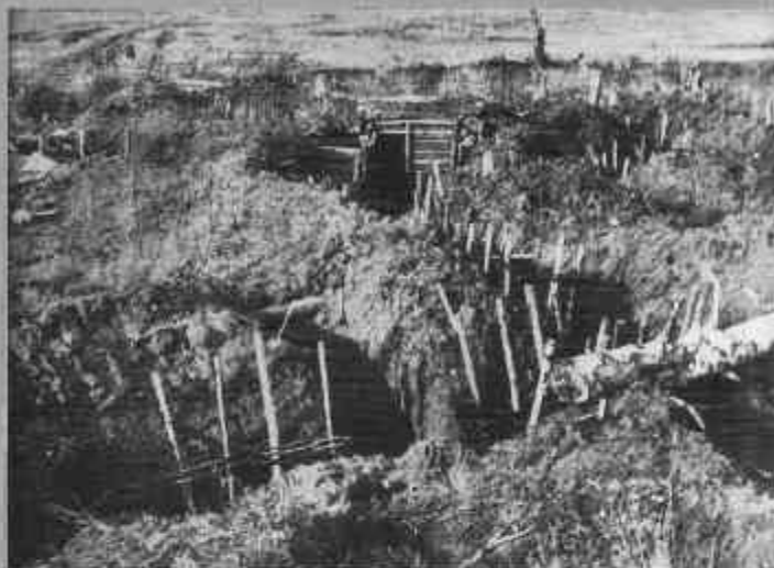
Октябрь 1943 г. Немецкие траншеи в Кирлидах после отхода немцев. Фото Д. Сивкина
